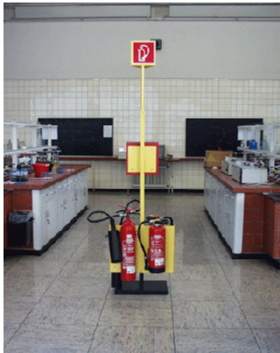
Abbildung 3: Im Falle eines Feuers müssen möglichst alle Praktikanten zügig den Praktikumssaal verlassen. Über die Verwendung der bereitgestellten Löschgeräten unterrichtet die Feuerwehr. Einmal im Semester werden Übungen veranstaltet.
