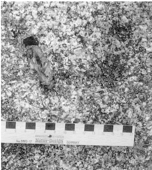
a) Aquädukt von Segovia, Ostseite, zentraler Teil des Inschriftenfeldes mit Dübellöchern. Foto: Verf. b), c) Aquädukt von Segovia, Dübellöcher (links mit Bleihülle und Bronzedübel). Foto: Verf.
